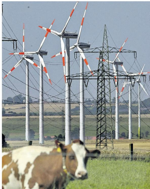
Die neuen Windkraftanlagen von Vesta sind inzwischen größer und höher: Sie haben einen Nabenhöhe von 140 Metern. Der Rotordurchmesser beträgt 112 Meter. Archivfoto: dpa
